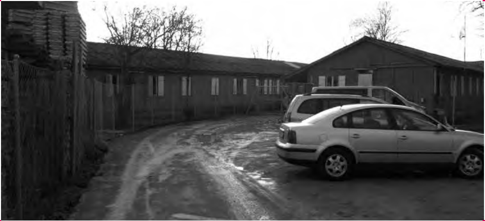
Test-Verfahrenszentrum Juch in Zürich Altstetten mit einer Kapazität von 300 Personen. Seit Januar 2014 testet das SEM in diesen Holzbaracken die geplante Restrukturierung des Asylwesens.
